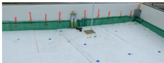
Kotvení desek EPS a EPS rozháněcích klínů
