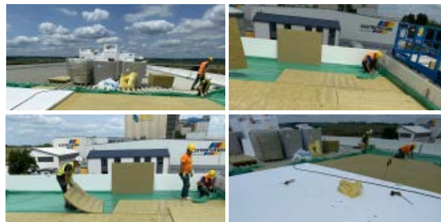
Kotvení desek EPS a EPS rozháněcích klínů
