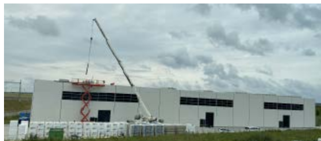
Pokládka parotěsné fólie, minerální vaty, EPS desek a klínů
