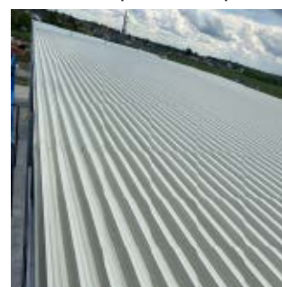
Montáž trapézového plechu
