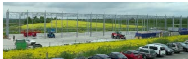
Montáž kovových nosníků
